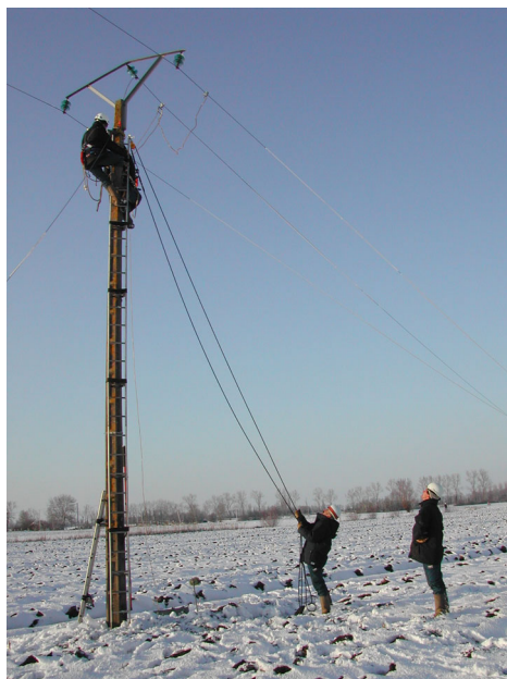
Réparation d'un poteau HTA.
