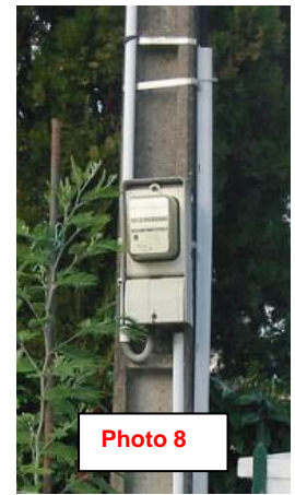
Compteur extérieur apparent
